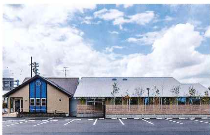
リニューアルが完了した外観。右側の建物がメンテナンス棟。
